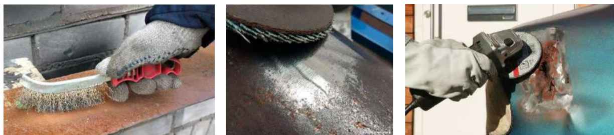
Рисунок 2 – Механическая обработка металла от коррозии
