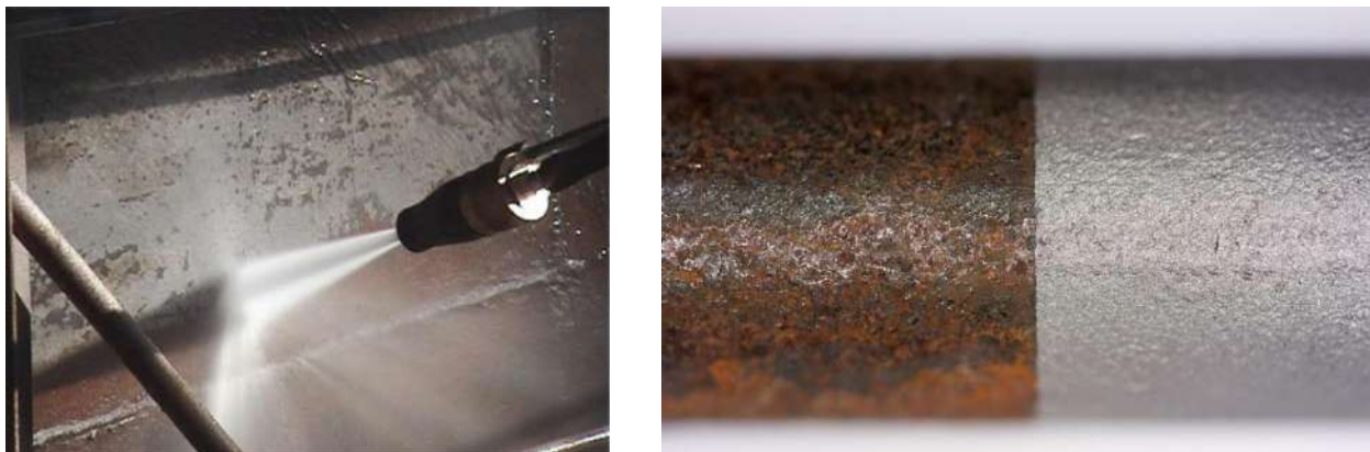
Рисунок 3 – Пескоструйная обработка металла от коррозии
