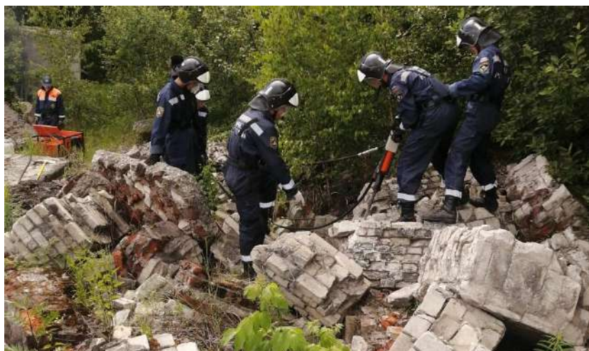
Рисунок 1 – Работа звена спасателей при устройстве галереи в завале кирпичного здания
