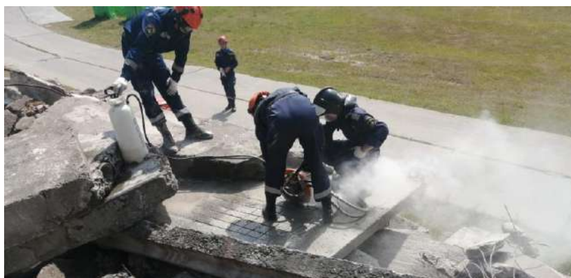
Рисунок 2 – Работа звена спасателей при устройстве галереи в завале панельного здания
