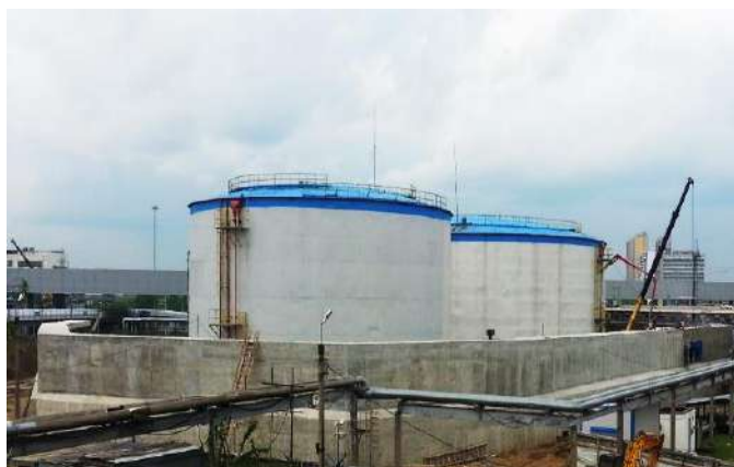
Рисунок 3 – Общий вид ограждающей стены с волноотражающим козырьком на стадии строительства в мазутном хозяйстве ТЭЦ-11 (Москва)
