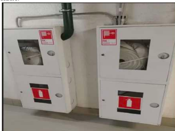
Рисунок 3 – Внутренний противопожарный водопровод
