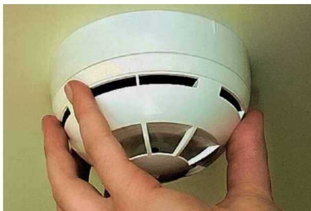
Рисунок 1 – установка автономного пожарного извещателя
