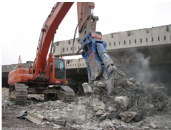
Рис. 2. Экскаватор с гидравлическими ножницами TREVI BENNE HC 40
