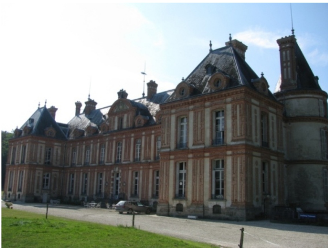
Рис. 3: замок Гравилль (Турнанфи). 1580-1586. Вид со стороны двора.
